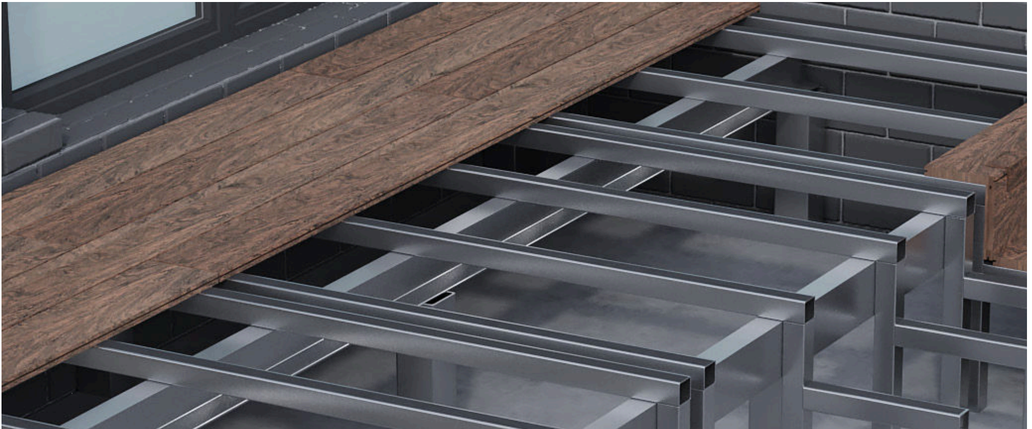
Installation des Metallgerüsts.
